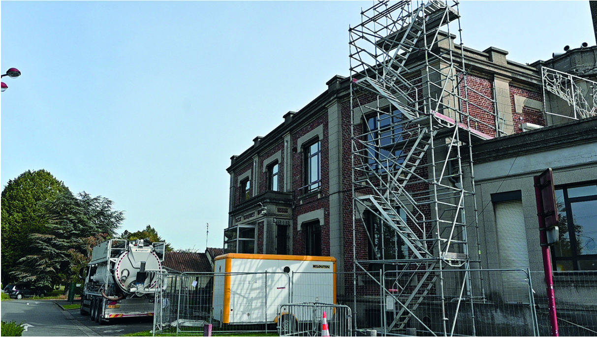
Travaux de toiture de la maison de la parentalité
