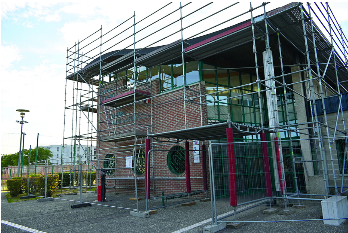
Travaux de toiture de l'ESCALE
