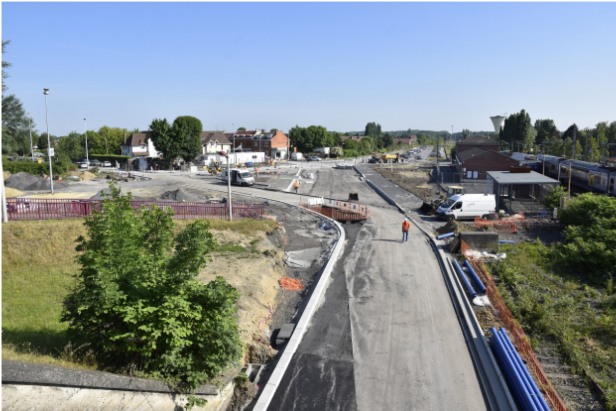
Travaux de l'éco-pôle gare
